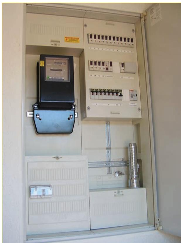
**Abb. 7.2** – Blick auf einen geöffneten Hausanschlusskasten.
