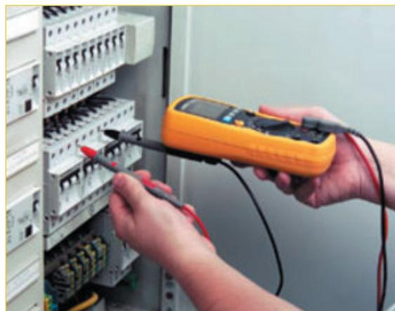
**Abb. 7.1** – Messen mit einem CAT-III-Schutz-Multimeter im Hausanschlusskasten. Die einschlägigen Sicherheitsvorschriften sind zu beachten.
