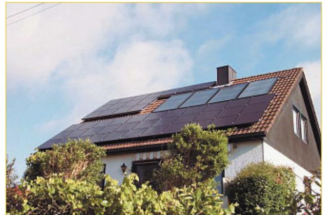
Abb. 11.11 – Große Solaranlagen mit amorphen Zellen sind bisher die Ausnahme. (Conrad)
