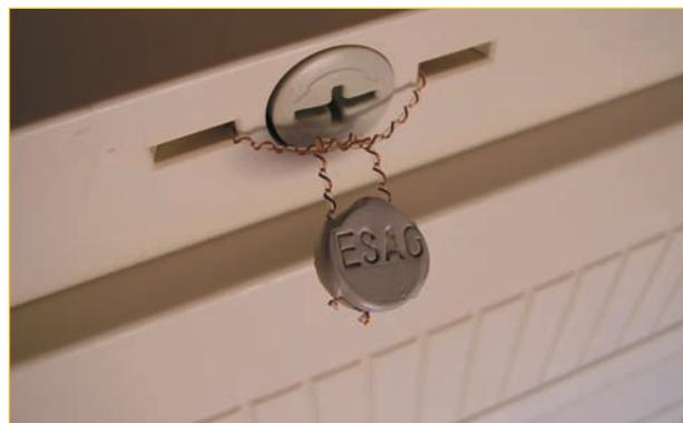
**Abb. 7.3** – Diese Plombe weist auf die Gebäude-Hauptsicherung hin.
