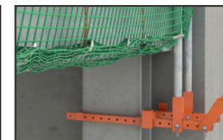
Doppelpostenkonstruktion am Endpfosten.
